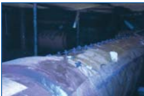
Ελεγχόμενη υγρή αφαίρεση με έκχυση
