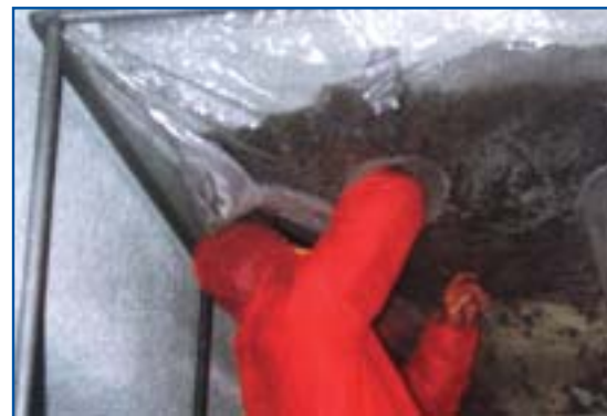
Αφαίρεση ψεκασμένης με αμίαντο επικάλυψης, με τη βοήθεια ειδικού σάκου με γάντια
