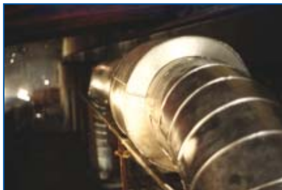
Εγκλεισμός σωληνώσεων που φέρουν μόνωση από αμίαντο
