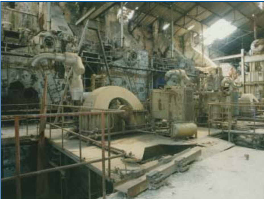
Εργοστασιακοί χώροι με εμφανή παρουσία αμιαντούχων υλικών
