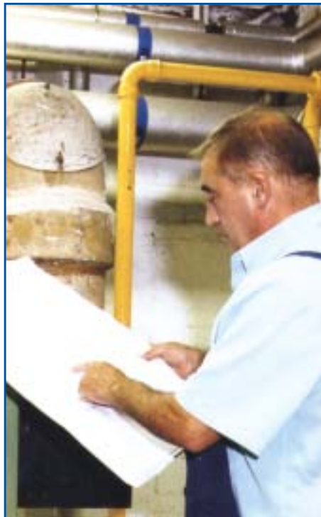
Έρευνα για ύπαρξη αμιαντούχων υλικών σε κτίριο
