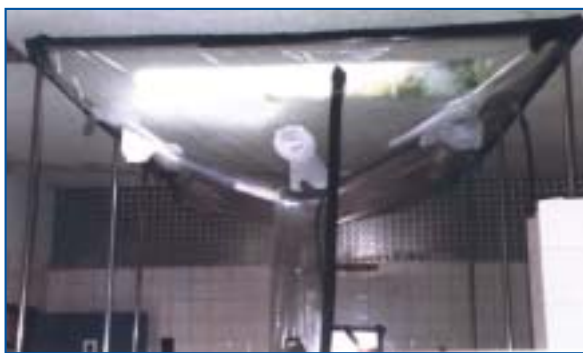
Σάκος με γάντια, σχεδιασμένος για την αφαίρεση επικάλυψης με ψεκασμένο αμίαντο
