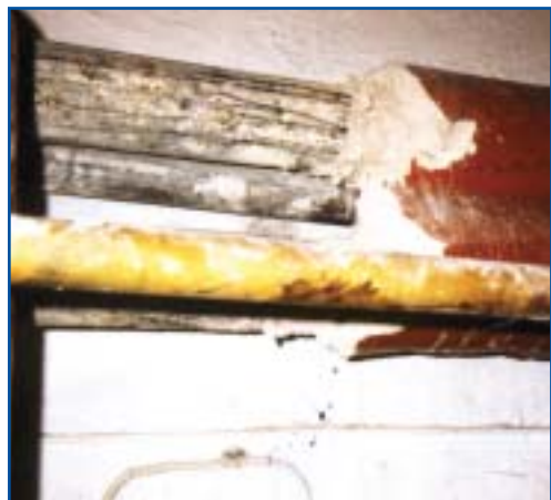
Παράδειγμα "hard set" μόνωσης σωλη- νώσεων που έχει μερικώς αφαιρεθεί
