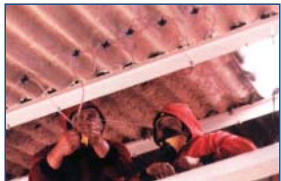
Ελεγχόμενη υγρή αφαίρεση με έκχυση
