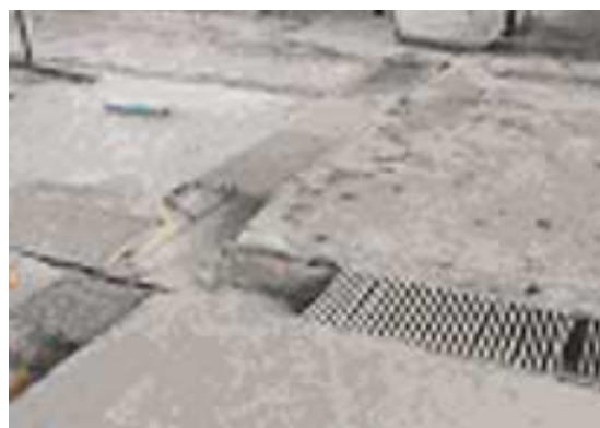
Σχήμα 2: Δάπεδο με ακατάλληλα καλύμματα καναλιών.
